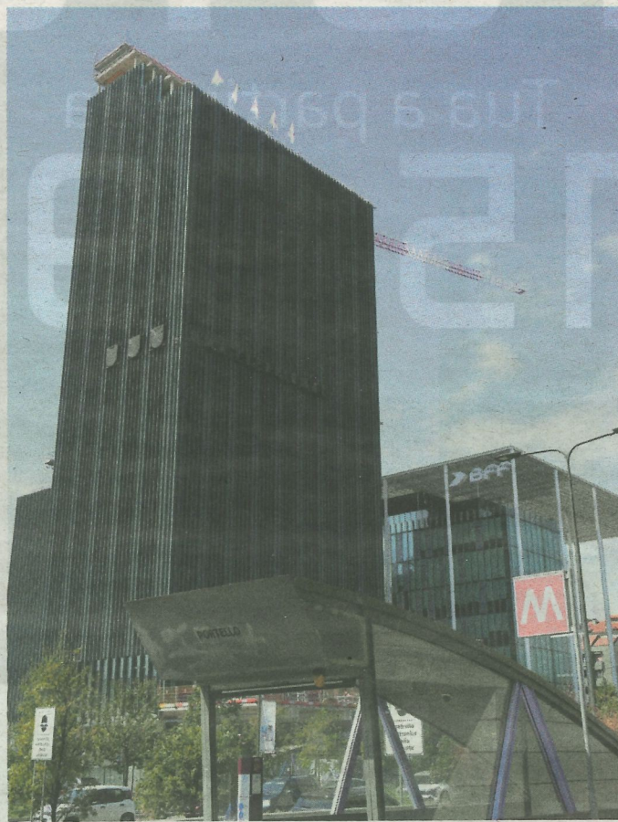
Il nuovo hotel in costruzione al Portello sarà alto 90 metri (Ipa)
